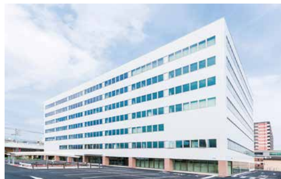
事務所の建物外観
