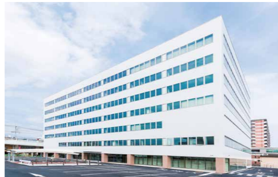
事務所の建物外観
