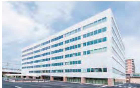
事務所の建物外観
